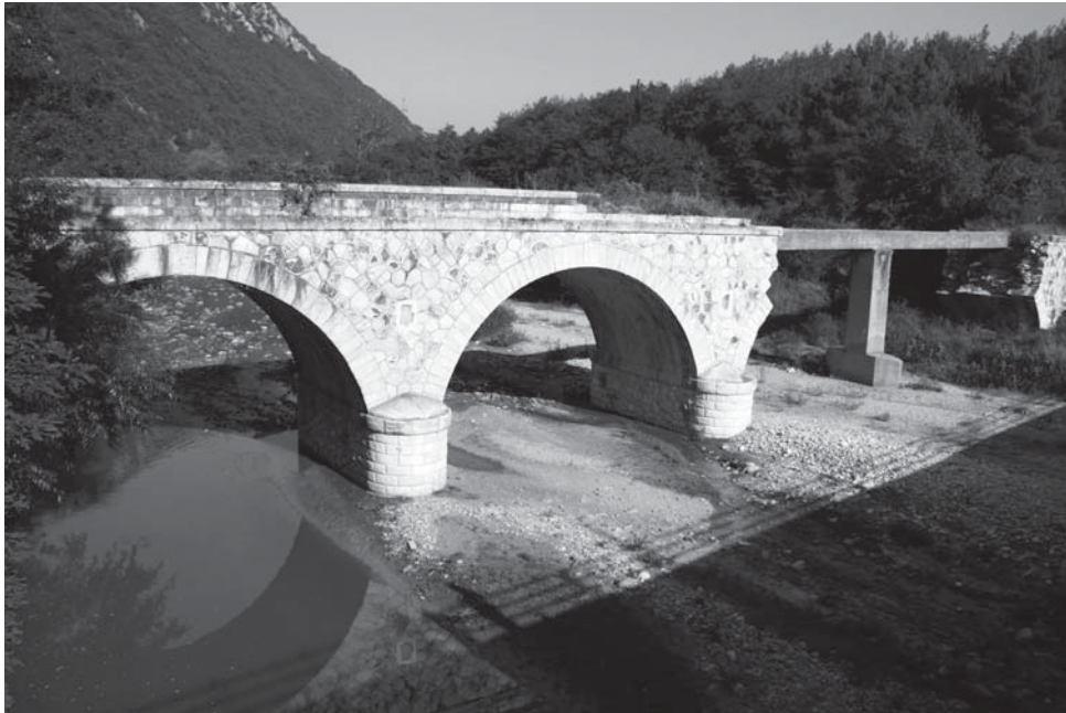
Abb. 2: Nomos Xanthi, sog. „Hamidiye Brücke“ oder „Brücke bei Kilometer 4“ (erbaut 1901).
