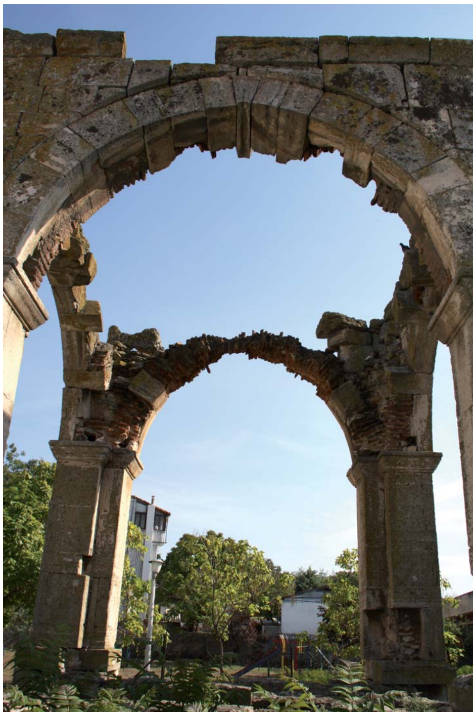
Abb. 9: Didymoteichon, Oruç Paşa Türbesi, ca. 1417.
